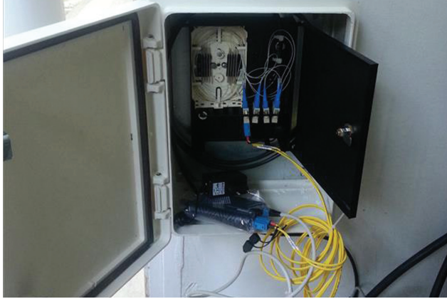
Elektrik Hattı Döşeme
