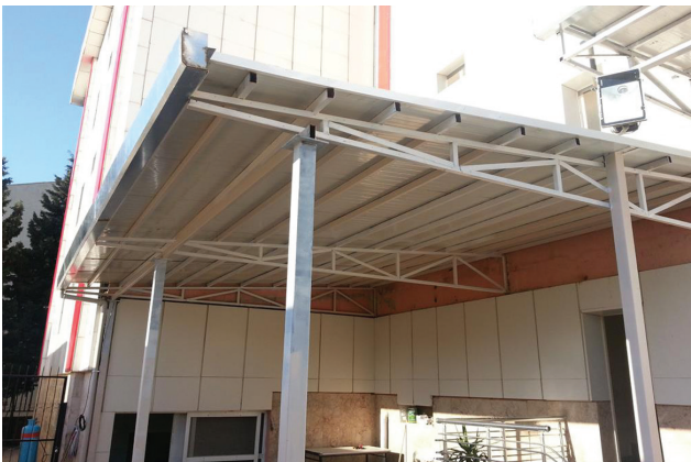
Mutfak Sundurma Çatı Yapımı
