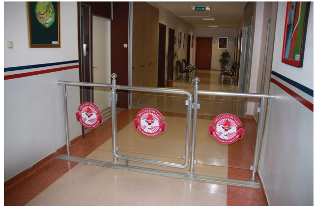
Yönetim Katlarına Bölme Yapımı
