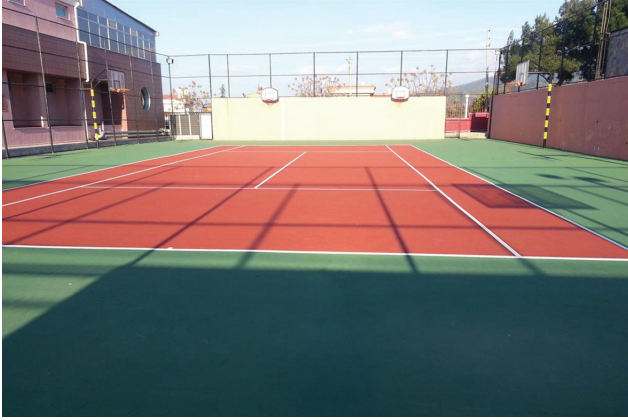
Tenis Kortu Zemin Tadilatı Yapımı
