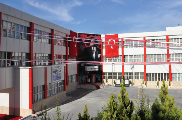
Dış Cephe Kaplama
