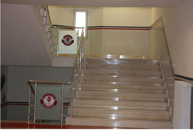
Merdiven Alüminyum Doğrama Yapımı
