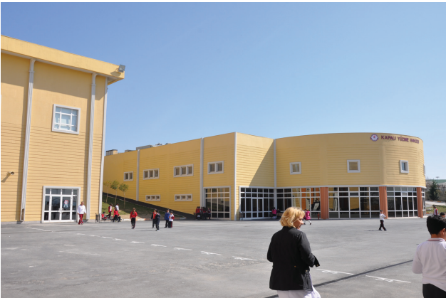
Dış Cephe Tadilat ve Boya Yapımı
