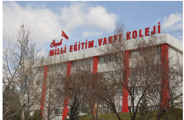
Led Işıklı Çatı Tabelası Yapımı
